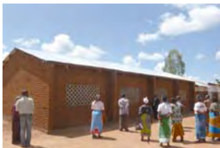
▲ 修復後の教室棟 1 を見ているところ (背面)
