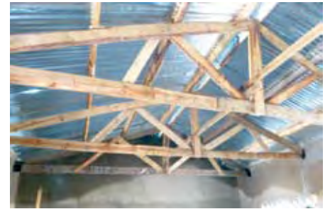
▲ 修復後の教室棟 1 の内観
