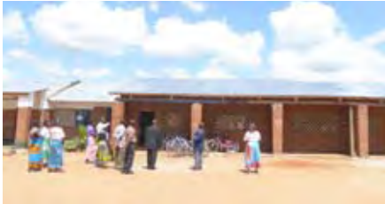
▲ 修復後の教室棟 1 を見ているところ (正面)
