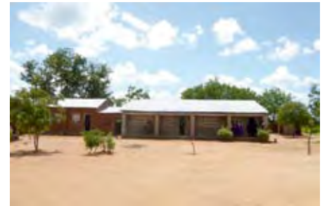
▲ 修復後の教室棟 3 の外観
